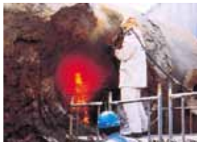
トビードカーの残鉄処理
