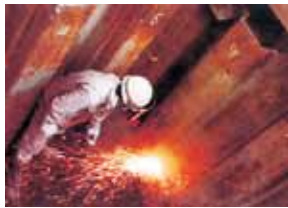
シートパイル溶断
