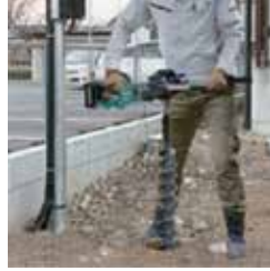
仮設電柱ポールの設置 その他現場作業に
