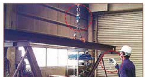
● 鋼材の吊上げ機の安全管理
