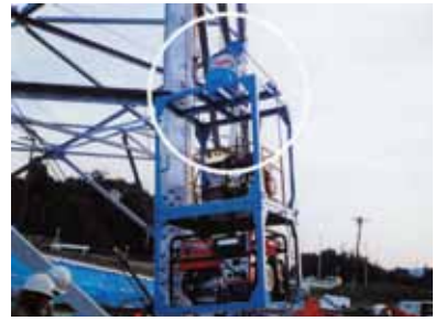
■鉄塔建設用 油圧PTレンチ吊り上げ装置
