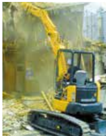
解体用つかみ機 （本造工作物を解体）
