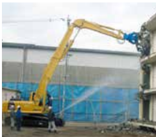
コンクリート圧砕機 （コンクリート構造物を砕く）
