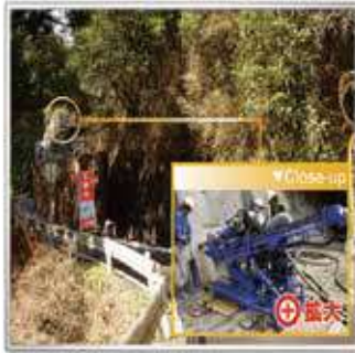
林道の限られたスペースでも施工可能。
