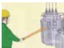
電源設備の温度管理
